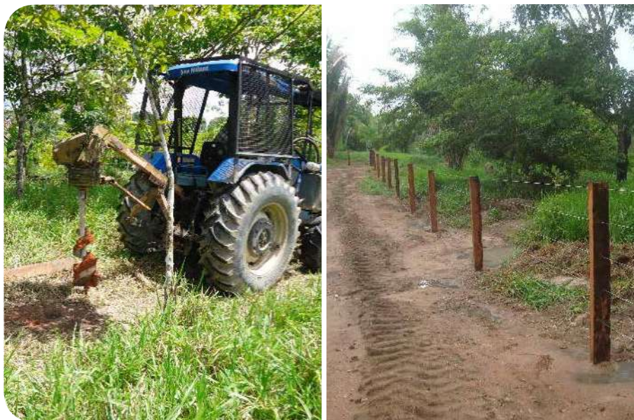
Figura 16 | Isolamento da área com cercas e arame na Fazenda São Nicolau, Cotriguaçu-MT.
